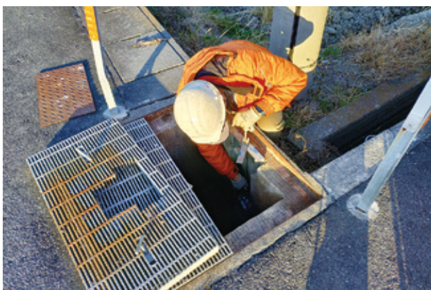
▲取入口蓋交換作業
